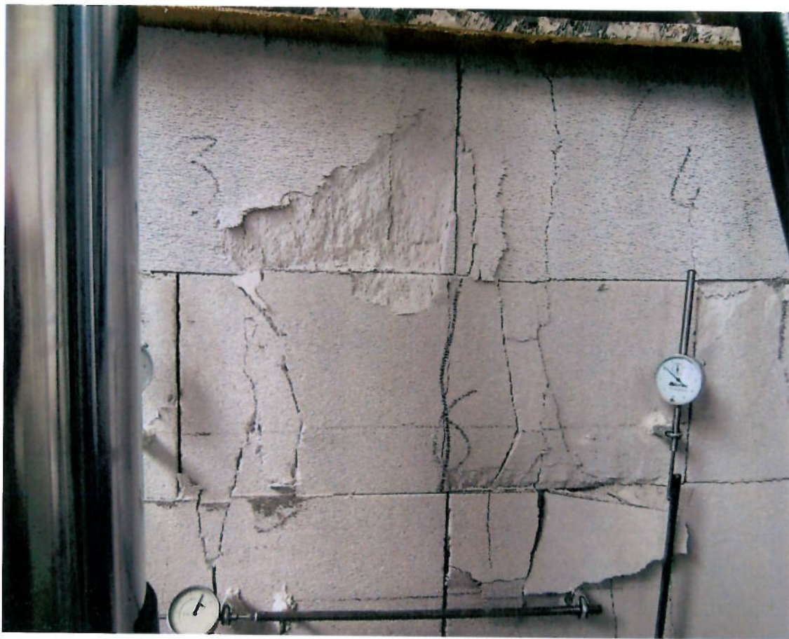
Фото 2. Разрушения образца кладки при максимальной нагрузке.
